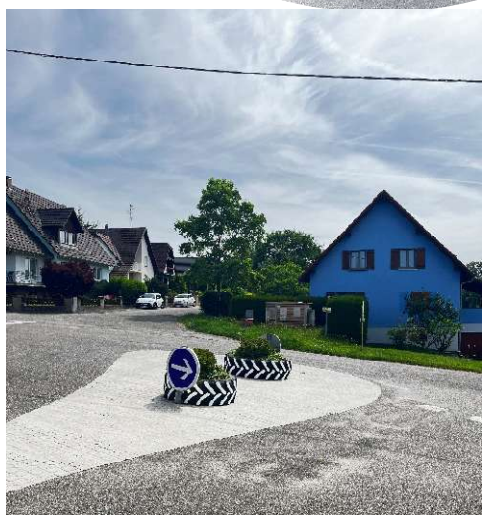
Réfection de la peinture des pneumatiques : croisement des Rues de Gersbach et de la Gare
