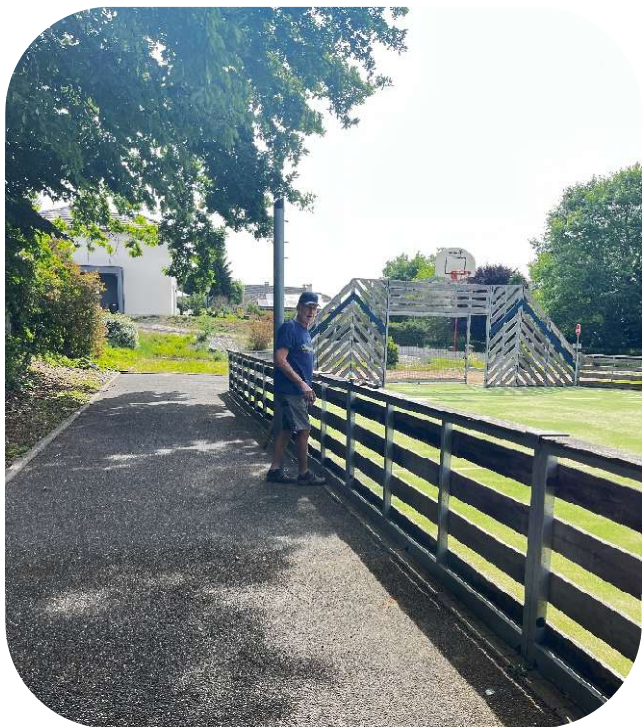
Remplacement des planches de la structure sportive
