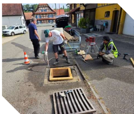
Pose d'une buse et création d'un regard
