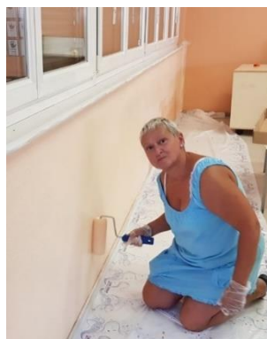
Dans la classe ABCM de l'école maternelle, l'adjointe Caroline Gutzwiller a effectué des travaux de peinture sur un mur
