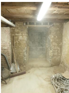
Changement d'une poutre abimée dans le sous-sol
