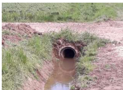
Pose d'une buse en béton armée au Langacker/Waldecker
