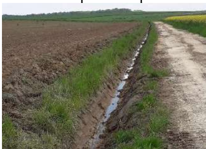
Curage des fossés au lieu dit Langacker/Waldacker
