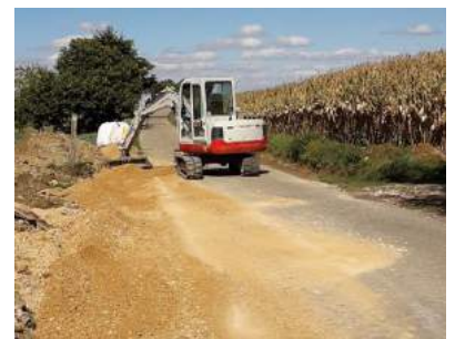
Finition du chantier avec la pelle d'un membre de l'AF
