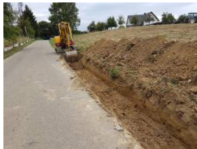
Réfection au Montagweg, avec pose d'un drainage
