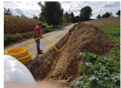
Pose des tuyaux de drainage
