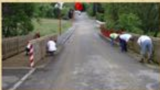
Passerelle Rue de la Fontaine
